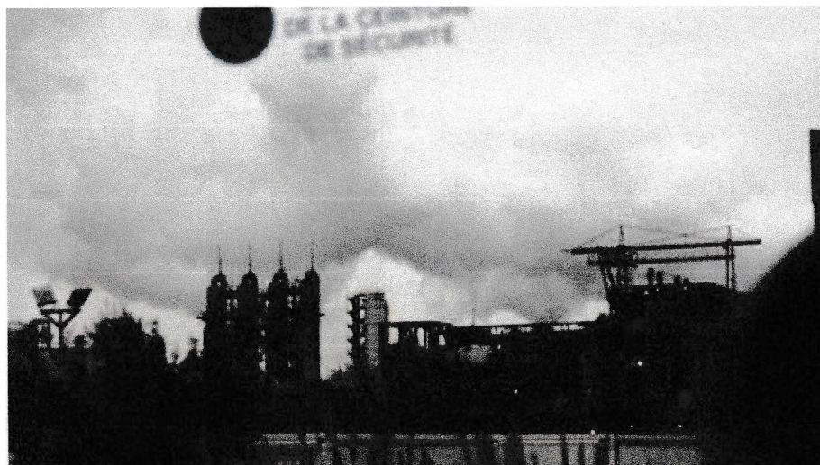
Sur le site Allo-industrie, Arcelor évoque un incident «minimes», provoqué par une simple «perte d'énergie électrique». Reste qu'il s'agit déjà du 3 e incident du genre en à peine six mois. PHOTO 12
